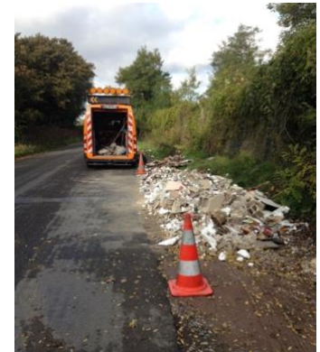
Sécurisation du bord d'une route départementale en vue du retrait du dépôt sauvage
