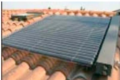
Un capteur solaire à tube sous vide est composé d'une série de tubes de verre transparent dans lesquels passe un tube collecteur de chaleur. Le vide à l'intérieur des tubes leur confère la particularité de limiter les pertes thermiques du capteur. De ce fait, il permet :
