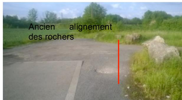
*Déplacement de l'enrochement : permet d'éviter une marche arrière de 243 m ou une manœuvre délicate*
