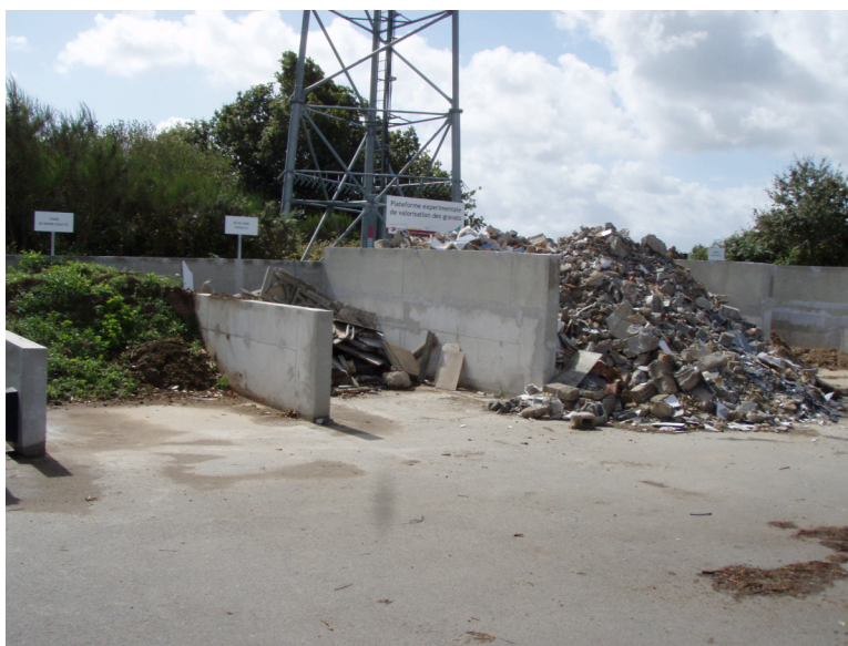
Déchèterie séparant les différents types de déchets inertes
