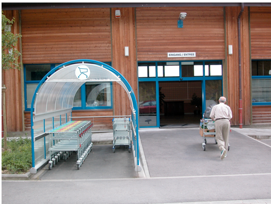
Entrée de la déchèterie
