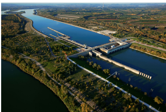
Centrale hydroélectrique de Beaucaire - photo Camille MOIRENC – photothèque CNR
