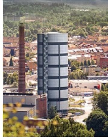
Figure 16: Exemple de réservoir aérien de 37 000 m<sup>3</sup> à Borås, Suède (source : Living circular-Veolia)
