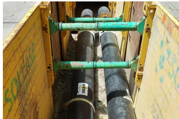
Réseau de distribution de chaleur sous la voirie
