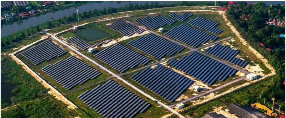
Fig 16. Exemple de parc photovoltaïque au sol – iStock
