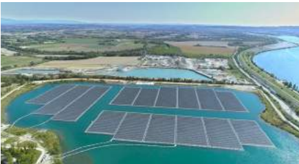
Fig 20. Installation photovoltaïque flottant à Piolenc - ©Akvo Energy - Hydrelío® by Ciel & Terre
