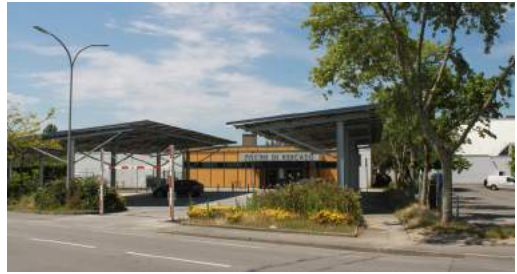
Fig 17. Ombrières photovoltaïques de parking public – Piscine de Mercado à Vannes - © 56 Energies
