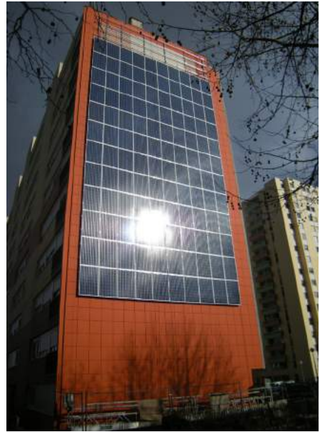
Fig 19. Exemple d'intégration photovoltaïque sur une façade Chenove (Côte-d'Or)
