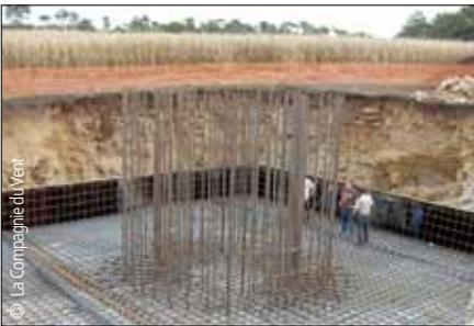
Le volume de béton présent dans les fondations est de l'ordre de 400 à 600 m<sup>3</sup> pour une éolienne de 2,5 MW (comparable au volume de béton et de parpaings utilisé pour la construction de 2 à 4 maisons).
