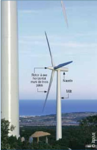
Figure 8 : Les éléments techniques d'une éolienne
