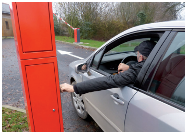
Contrôle d'accès par barrière avec borne de lecture.
