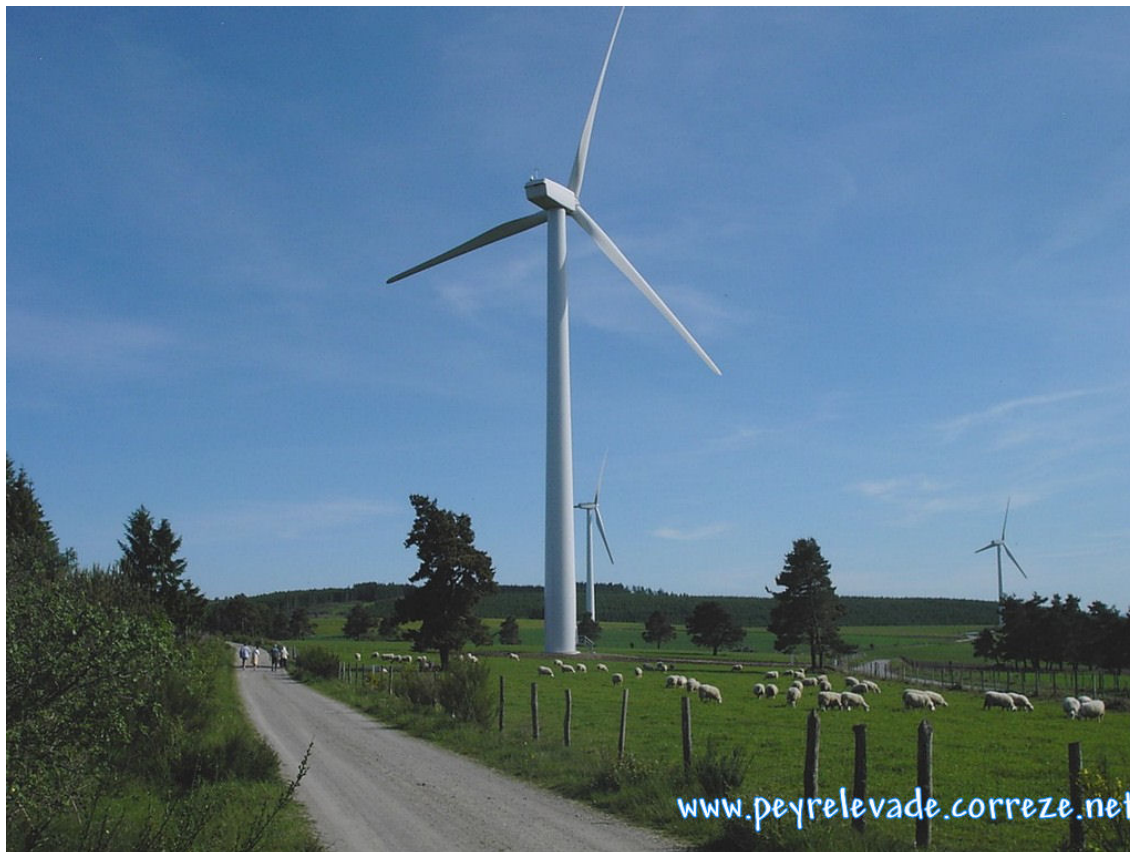
Figure 17 : Parc éolien de Peyrelevade Source : Mairie de Peyrelevade
