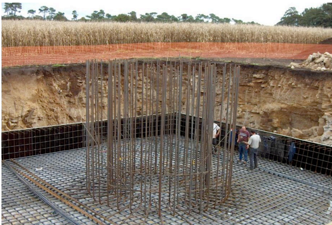
Figure 12 : Fondations d'une éolienne Source : Compagnie du Vent
