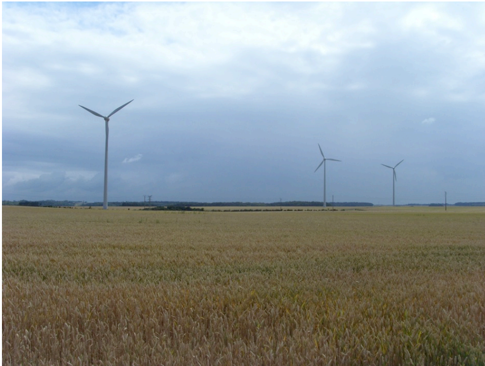
Figure 2 : Parc Eolien en milieu agricole Source : SER
