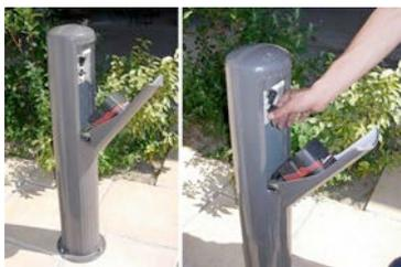
La collecte des bacs est réalisée en régie au moyen d'une benne à ordures ménagères de gabarit réduit, de PTAC 12 tonnes. La montée et la descente de chaque ascenseur sont actionnées par l'agent de collecte, via le branchement d'une batterie portable sur un potelet muni d'un moteur basse tension 24V, situé à proximité de chaque ascenseur (temps de montée ou descente de l'ascenseur d'environ 20 secondes).
