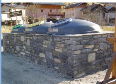
Les conteneurs sont de marque **SERACc®France**, de capacité 5m<sup>3</sup> pour les OMR et les EMR+papiers en mélange et de capacité 3 m<sup>3</sup> pour le verre, à préhension simple crochet. Le couvercle et la cuve du conteneur sont en PEHD habillés, pour une large majorité, en parement de pierres et sur certains sites de lattes de bois pour favoriser leur intégration paysagère. Le récipient de stockage des déchets est souple (appelée sac de portage).
