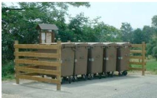
Les principaux aménagements consistent en la réalisation d'une dalle en béton pour **49,1%** des collectivités, parfois nécessaire quand le terrain est en pente ou en terre. Cette dalle est en général complétée par la réalisation d'un enclos en bois, d'une rambarde métallique ou encore de murets périphériques pour masquer visuellement les conteneurs. Des investissements en caches-conteneurs totalement fermés avec des couvercles d'introduction des déchets dans les
