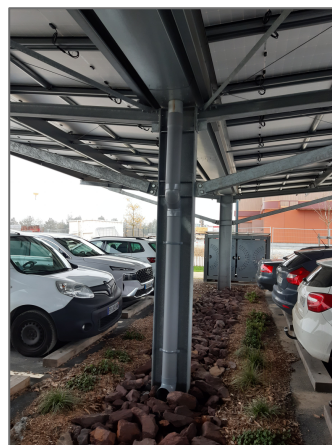
Figure 19 : Exemples d'ombrières en Y sur le projet du parking de Liffré (Ille-et-Vilaine)
