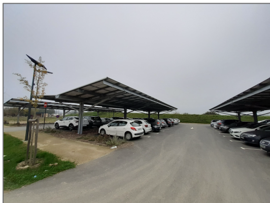
Figure 19 : Exemples d'ombrières en Y sur le projet du parking de Liffré (Ille-et-Vilaine)
