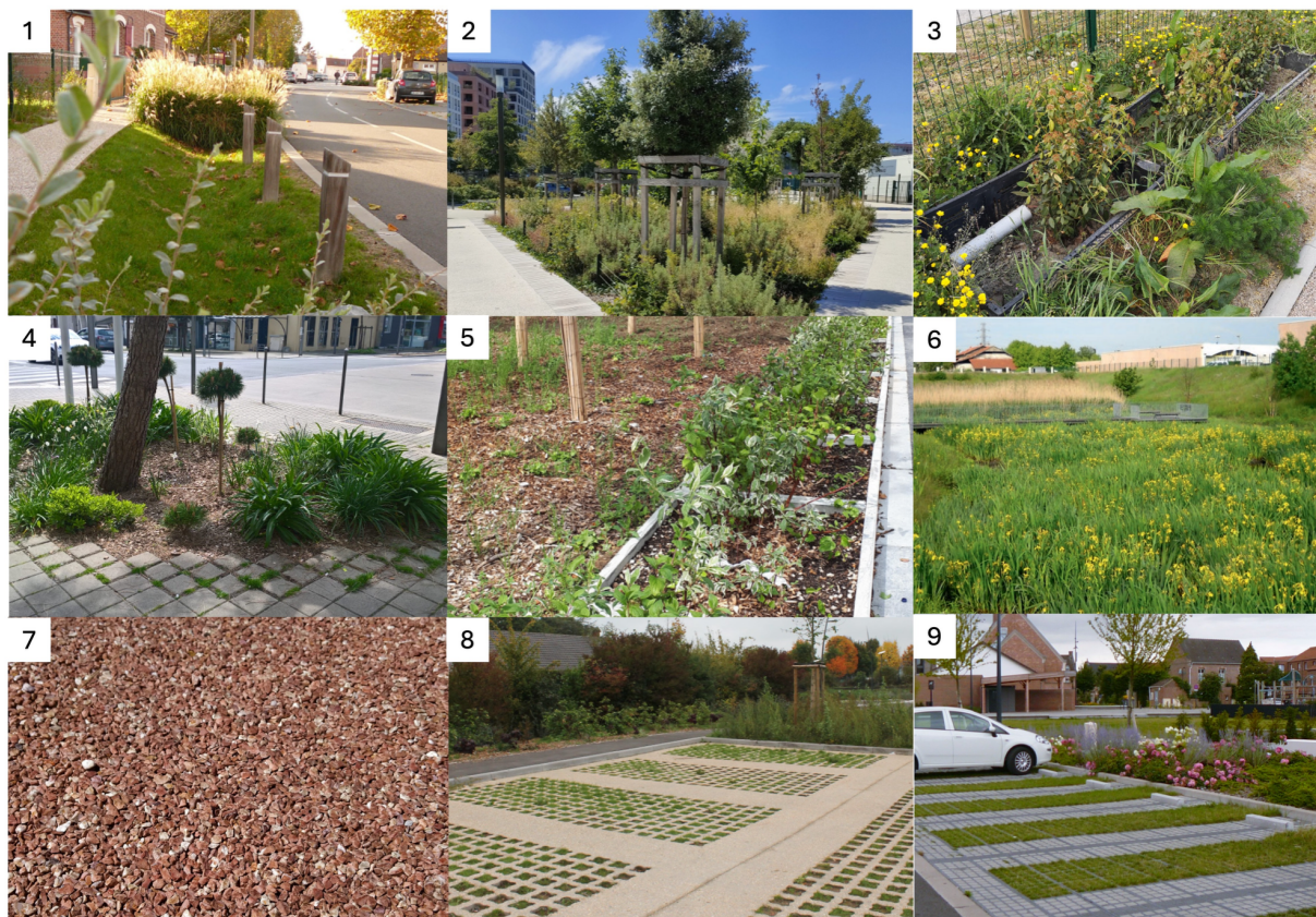
Figure 14 : illustration d'exemples d'ouvrages d'infiltration des eaux pluviales - Crédits photos : Adopta & OTHU
