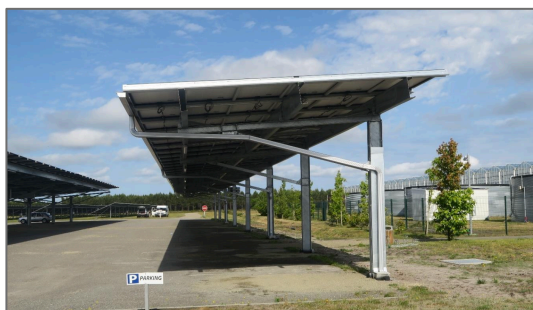
Figure 17 : Exemple de chéneaux intégrés à une installation d'ombrières PV avec descente des EP le long des poteaux (schéma de droite, mesures en mètres)
