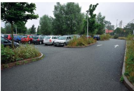
Parking avec enrobés poreux à structure réservoir – parking Saint Philibert, Lomme
