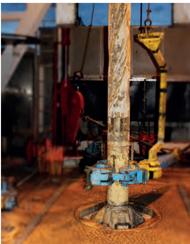
Chantier de forage d'Arcueil
