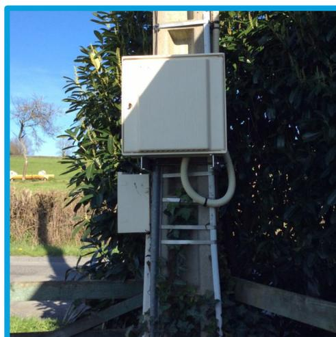
Figure 12 : Exemple de boîtier sur poteau contenant un équilibreur de réseau, installé dans le cadre d'une opération MDE
