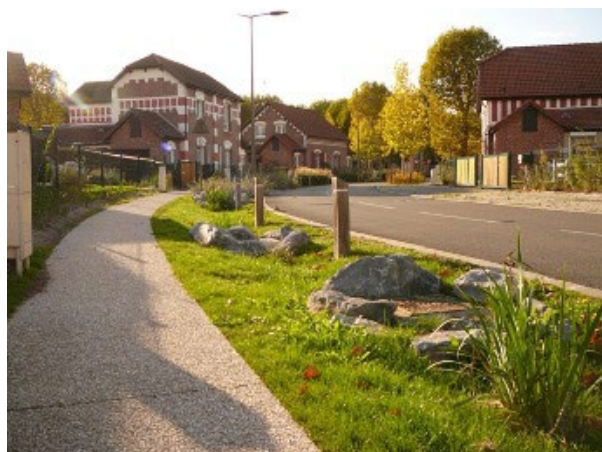
Noue d'infiltration (Source : Adopta)
