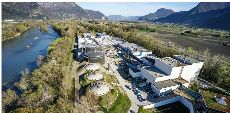
Station d'épuration d'Aquapole de 500 000 EH de Grenoble Alpes Métropole (source : Grenoble Alpes Métropole)
