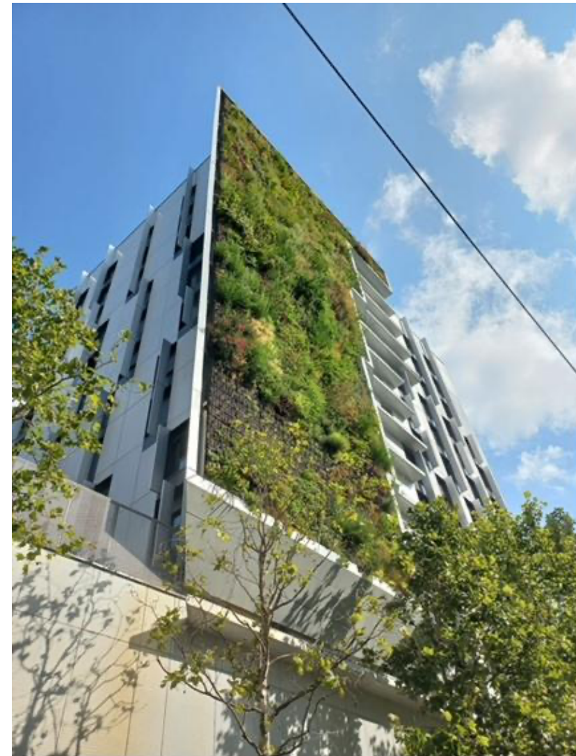
Façade végétalisée de 400 m 2 composée de plantes dites fragiles!
