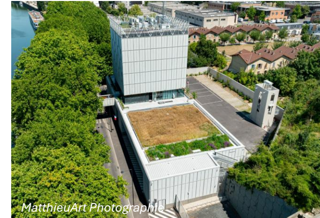
Vue aérienne sur le centre de secours
