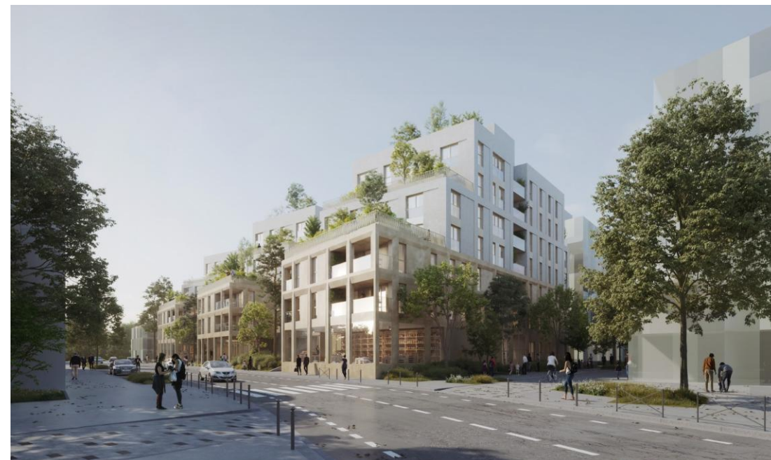
Greenside, 3 îlots, 67 logements locatifs sociaux et 31 accessions Bail Réel Solidaire, 3 locaux d'activité, 1 crèche inclusive. construction biosourcée projet labellisé Habitat HQE 2*
