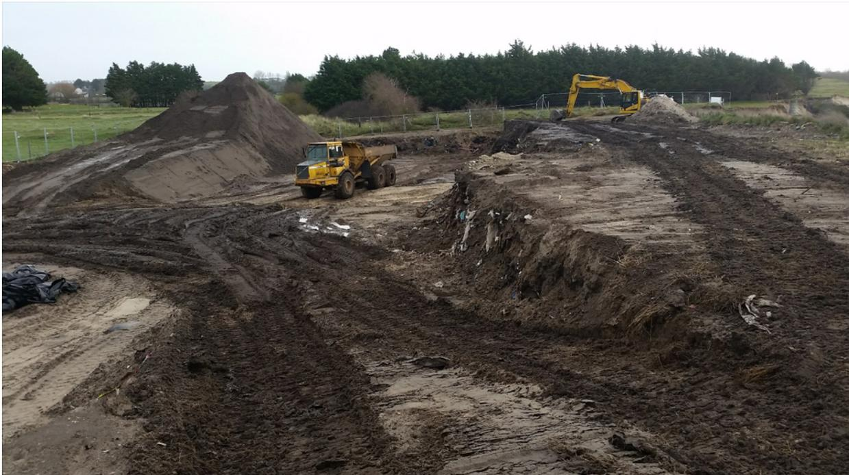
*Photo de l'extraction des déchets avant transport vers la plateforme de criblage.*
