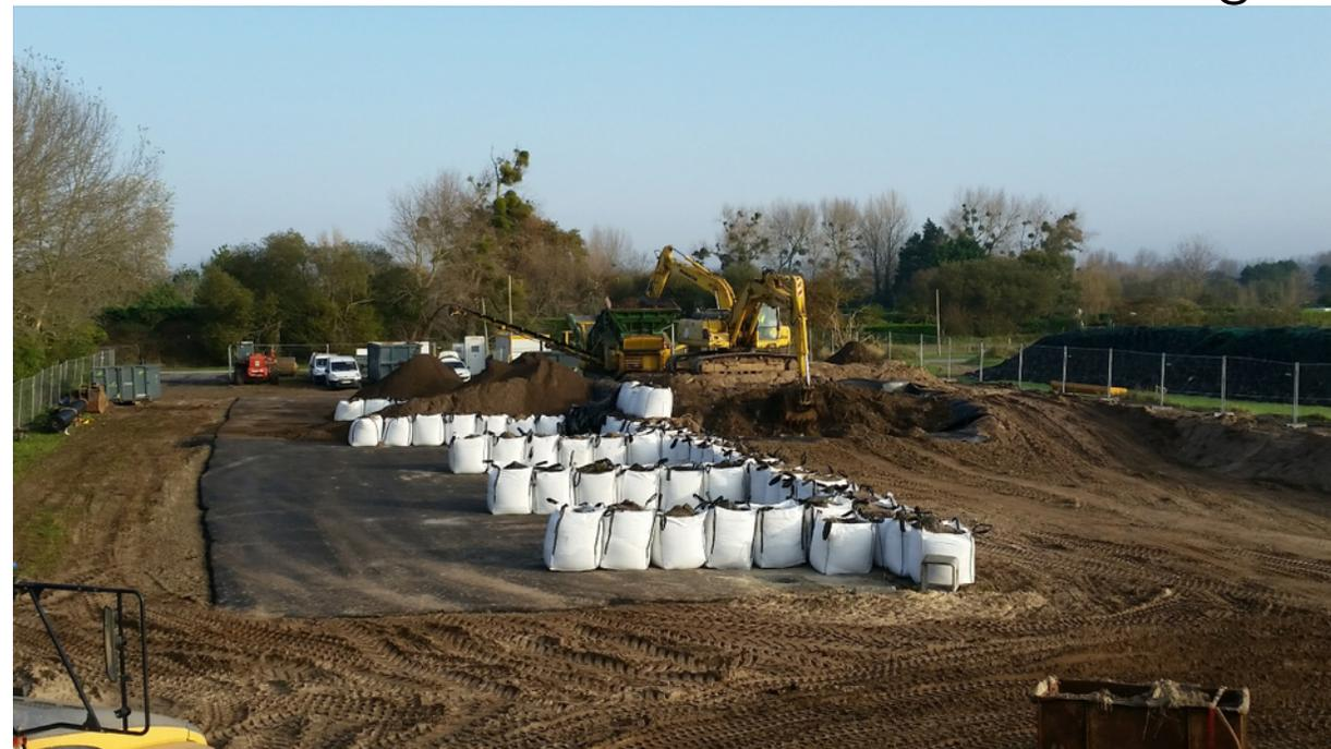
*Photo de la plateforme de criblage adjacente au site. La partie goudronnée sur rétention sert d'entreposage des fines en attente des retours d'analyses.*
