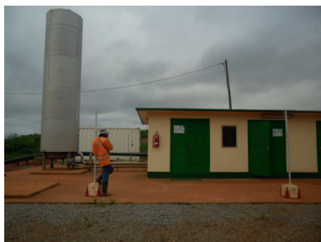
Photographie 1. Projet MDP de Nkol Foulou
