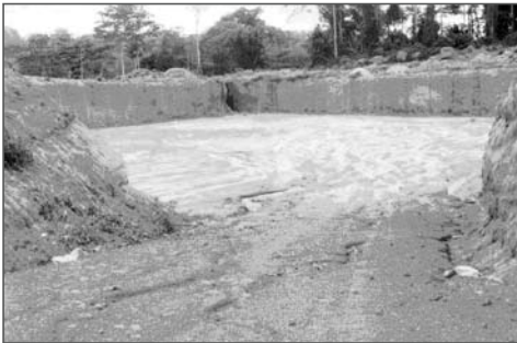
Photo 15 : Un casier en cours de construction à la décharge de Yaoundé
