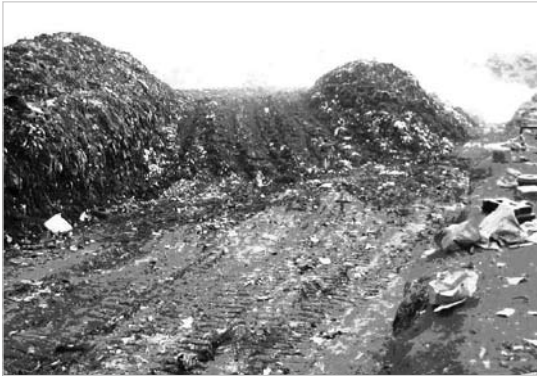
Photo 1 : Un casier d'une décharge traditionnelle en cours d'exploitation
