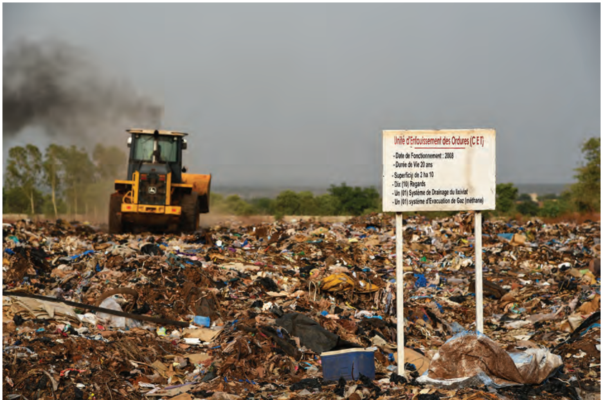
Un chargeur étale les déchets au CET.
