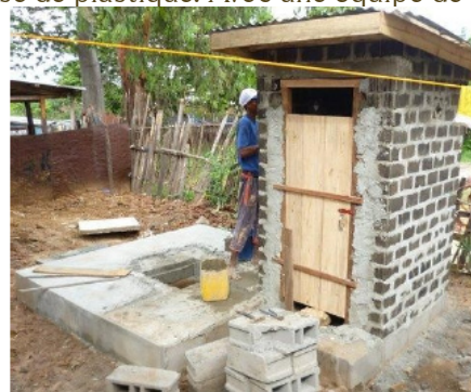
Illustration 5: Latrines construite à partie des briques sable-plastique
