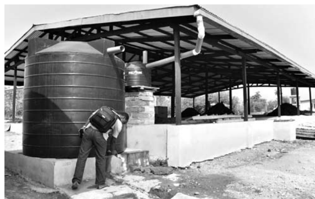
Photo 6.1 : Le système de captage d'eau de pluies dans l'installation pilote de co-compostage à Koumassi au Ghana. Le petit «réservoir du premier jet» situé à l'arrière du grand réservoir, collecte les premières pluies qui arrivent, détournant la poussière et les saletés du toit. (Sandec)
